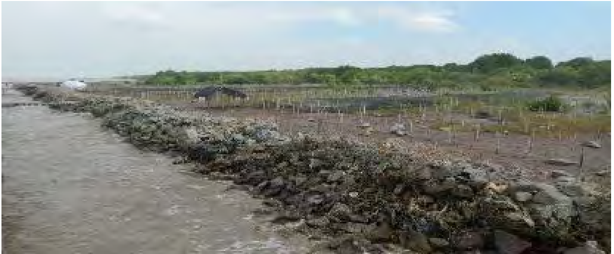
Fig. 19. Riprap embankment protection. Source: Holger Schuettrumpf & Peter Froehle
