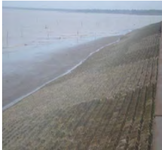
Fig. 28. Interlocking concrete slab armouring. Source: Holger Schuettrumpf & Peter Froehle
